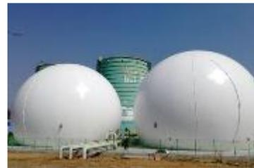
(Arkansas). È nata dall'evoluzione delle prime coperture di impianti agricoli per la produzione di biometano verso strutture altamente tecnologiche di stoccaggio gas nel settore agricolo-industriale e di trattamento delle acque.
